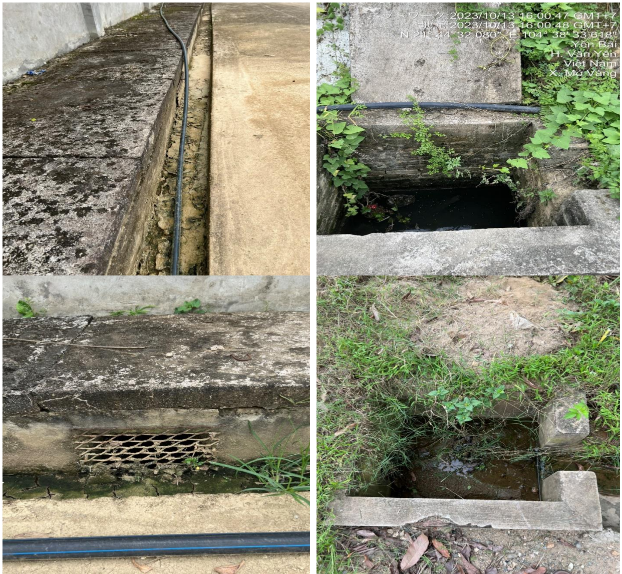
Hình 8. Rãnh thu nước mưa nhà máy và khu quản lý vận hành
